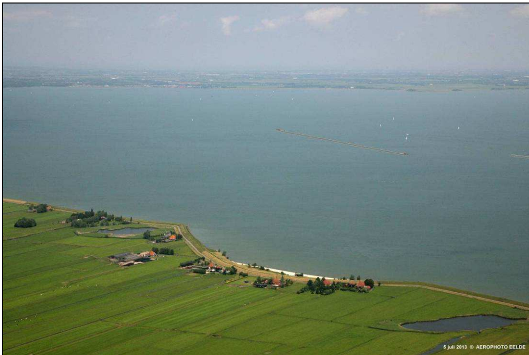
Figuur 4.5 Impressie van de dammen gezien vanuit de lucht boven de Grote Braak en de Moordenaarsbraak[Bureau Strooming, 2013]
