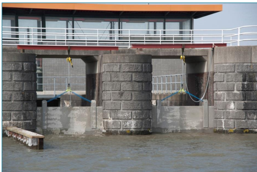
Figuur 4: noodshuiven om extra lokstroom mee in te stellen
