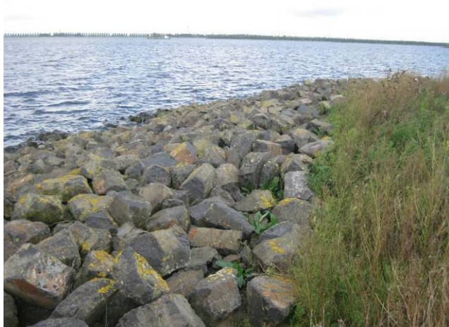
Afbeelding 3.8: Stortstenen oeververdediging met daaronder geotextiel
