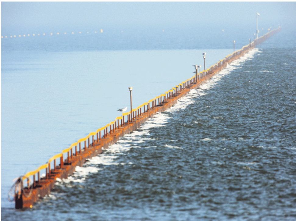
Figuur 4.12a: Aanzicht gerealiseerde luwtestruktuur met links de luwe zijde
