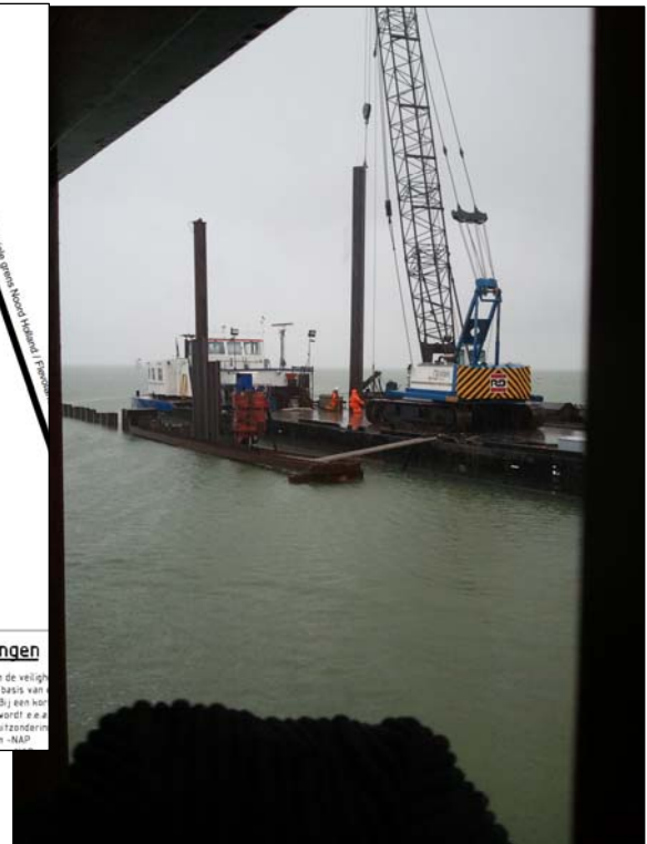
Figuur 4.12: Plaatsing luwtestruktuur
