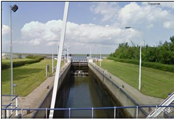
Figuur 8-12: Verlichting bij sluisen Blocq van Kuffeler
