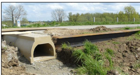
Figuur 8-8: Voorbeeld faunapassage in aanleg in de kroon van een dijk, met geleidingsstructuur
