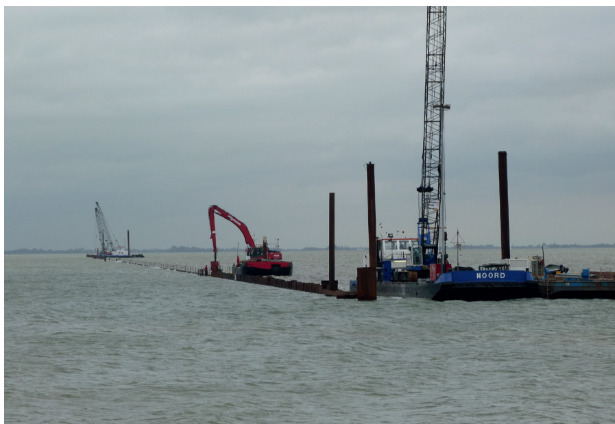
Verwijderen van de luwtedam nabij Warde
