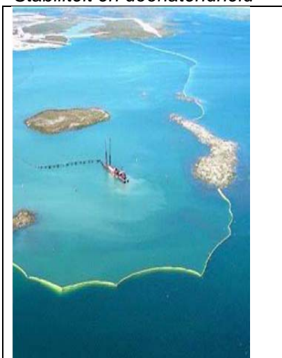
Figuur 2.7: Toepassing slibschermen bij baggerwerkzaamheden
