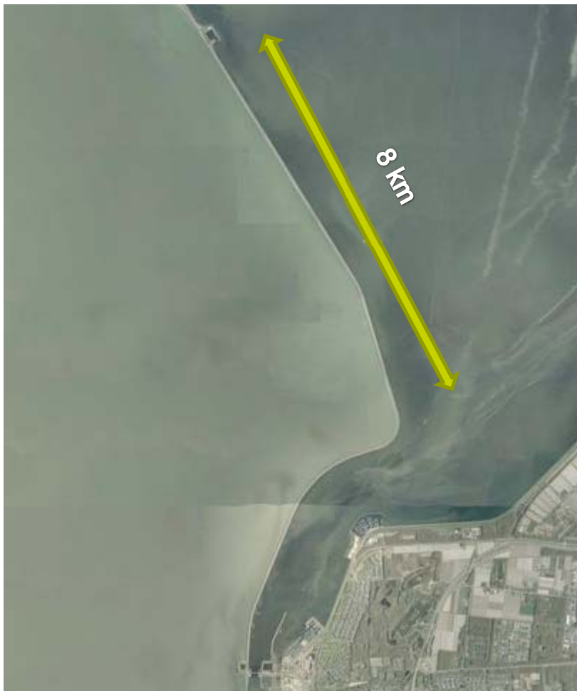
Figuur 19: Luchtfoto Houtribdijk tussen Trintelhaven en Lelystad
