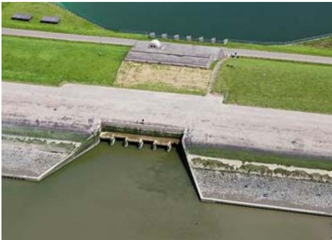
Figuur 23: Bathse spuisluis, bouw gereed 1987
