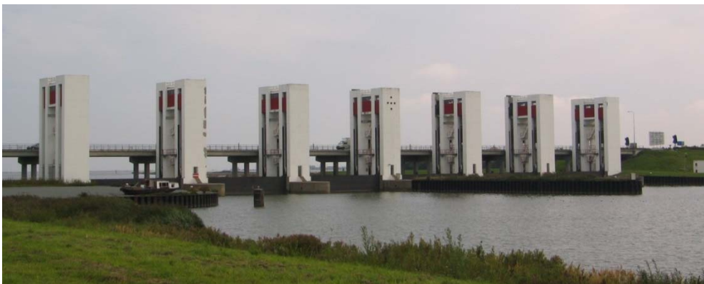
Figuur 22: Spuisluizen Houtribdijk: totaal 100 m opening in 6 sluizen
