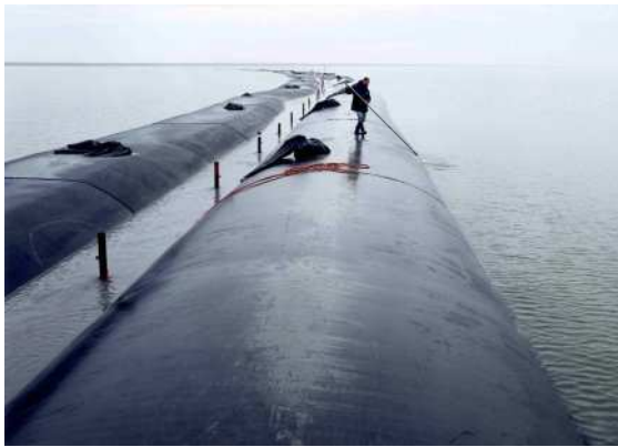
figuur 18: Toepassing van twee geotubes bij het Naviduct te Enkhuizen.
