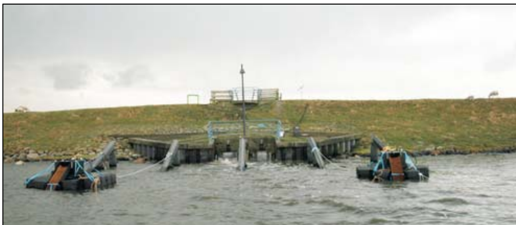
Figuur 5.7: Aanzicht van gemaaluitlaat met twee drijvende glasaaldetectoren
