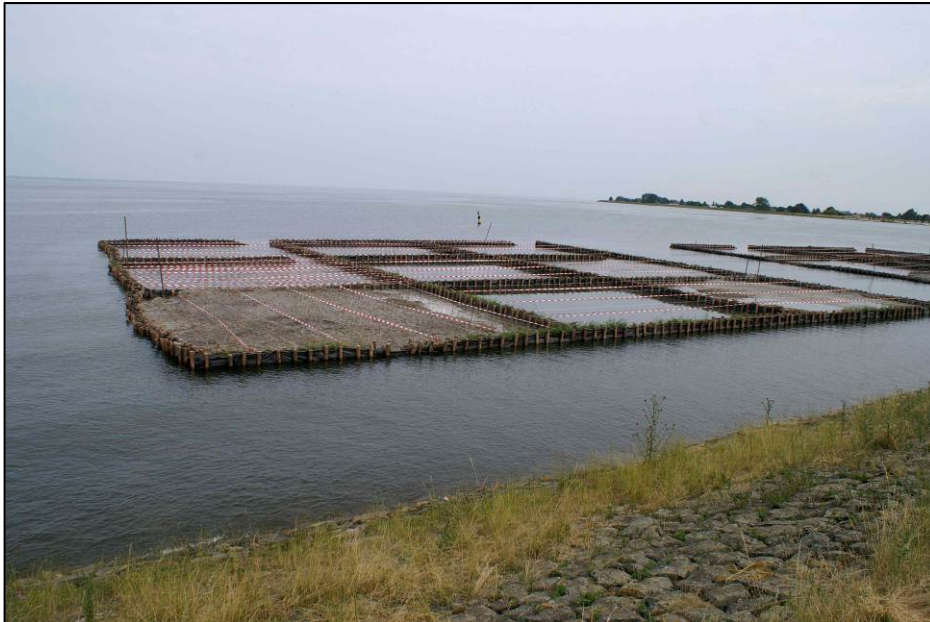
Figuur 4.22: Beeld van de Markerkwelderwerken na aanleg
