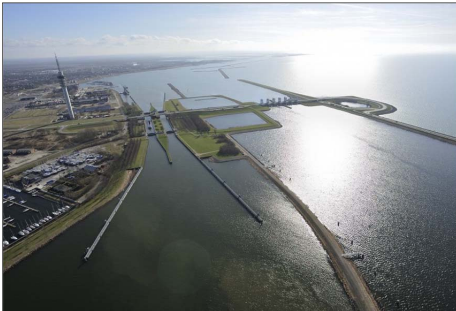
Figuur 5.1: De Houtribsluizen zijn beperkt passeerbaar voor vis. In de Planstudie Rijkvispassages (2011) is de maatregel van kattenluiken voorgesteld om de passeerbaarheid te vergroten
