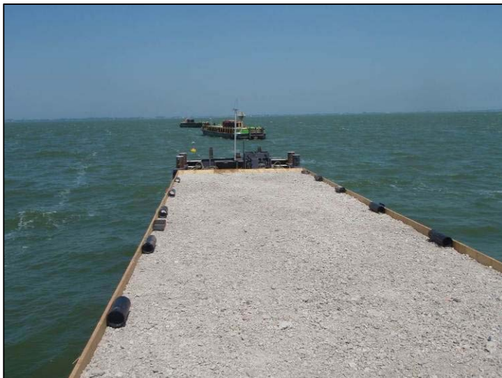
Figuur 5.10: Bovenaanzicht kunstmatig vogeleiland, meteen na aanleg
