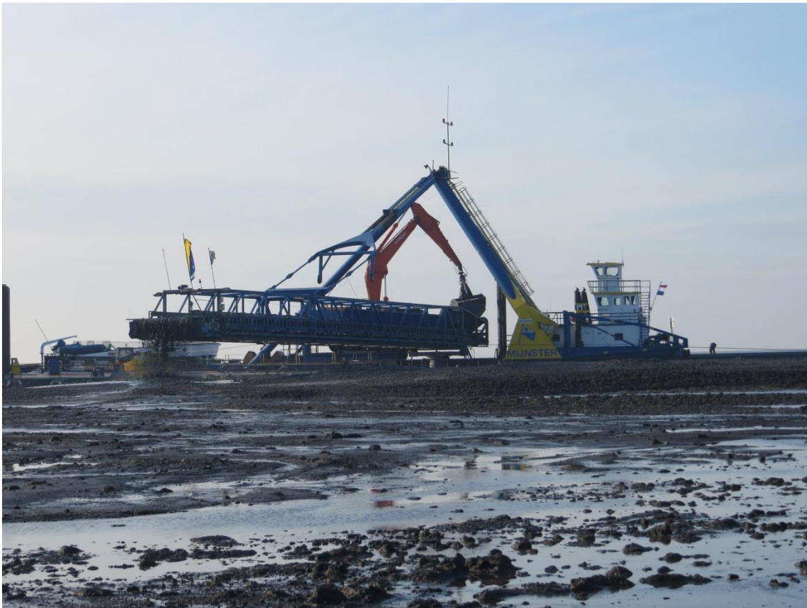
Figuur A.2 Het storten van het holocene materiaal met een transport band
